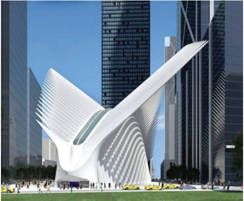
С. Калатрава. Станція Нью-Йоркського метрополітену
